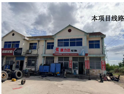
图2-1 110kV召宋线高岛支线003号-004号线路东侧13m，康力达轮胎修理厂
