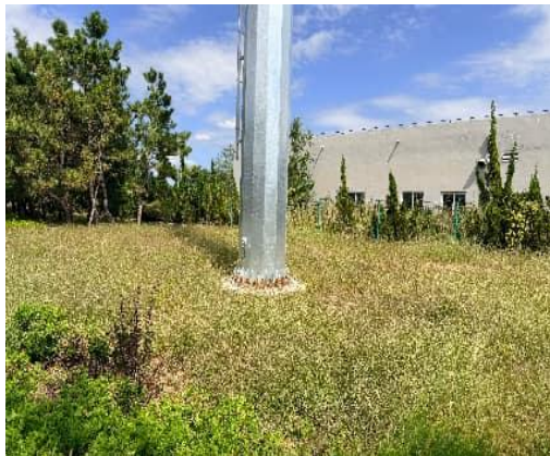
图 6-1 110kV 召宋线高岛支线 044 号塔基周围恢复现状
