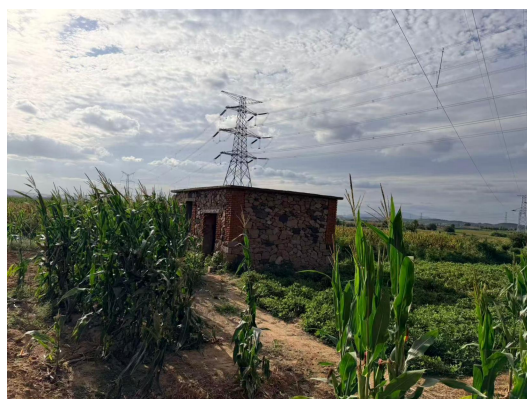
图2-5 110kV召宋线高岛支线015号-016号线路西侧2m，小洛村东侧种植看护房
