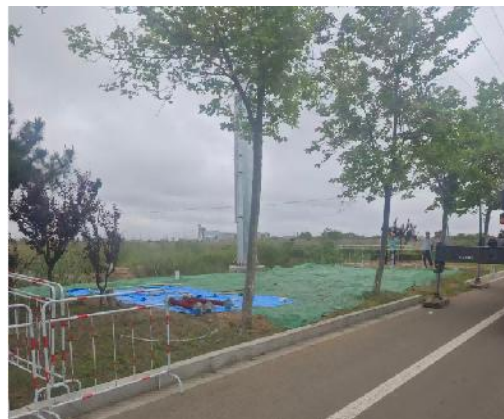
图 6-6 施工期间防尘网
