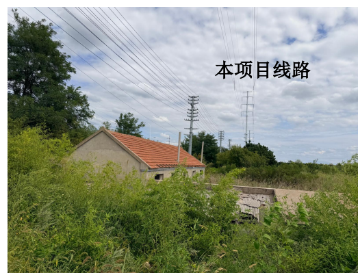
图2-10 110kV召宋线高岛支线047号-048号/ 110kV备用线路线下，南廐村西南侧民房
