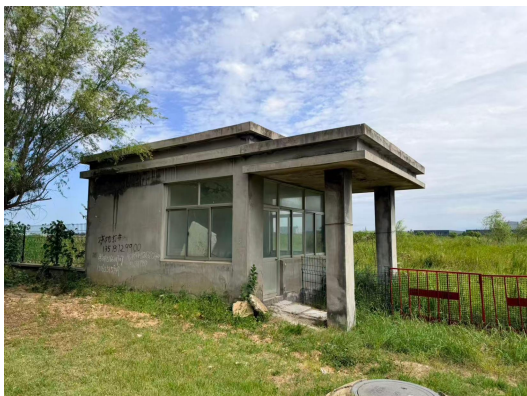
图2-7 110kV召宋线高岛支线039号-040号线路东侧11m，门卫室1
