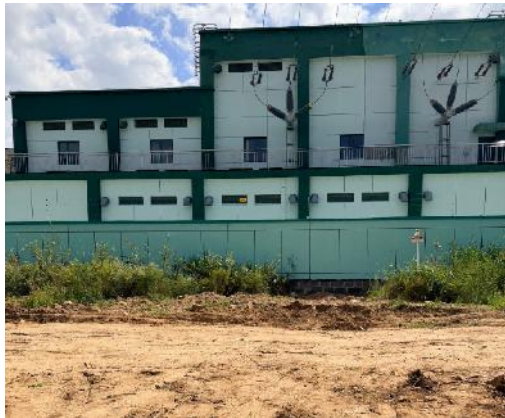
图 6-3 110kV 召宋线高岛支线电缆上方恢复现状
