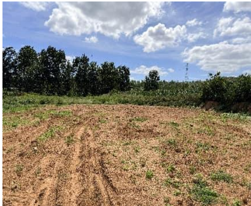
图 6-4 临时道路恢复现状
