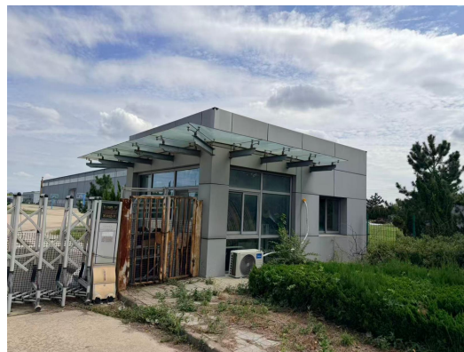
图2-8 110kV召宋线高岛支线044号-045号线路东侧17m，威海现代风电科技有限公司门卫室
