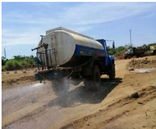
图 6-5 施工期间洒水作业
