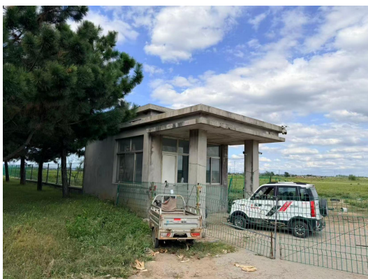
图2-9 110kV召宋线高岛支线035号-036号线路东侧4m，门卫室2
