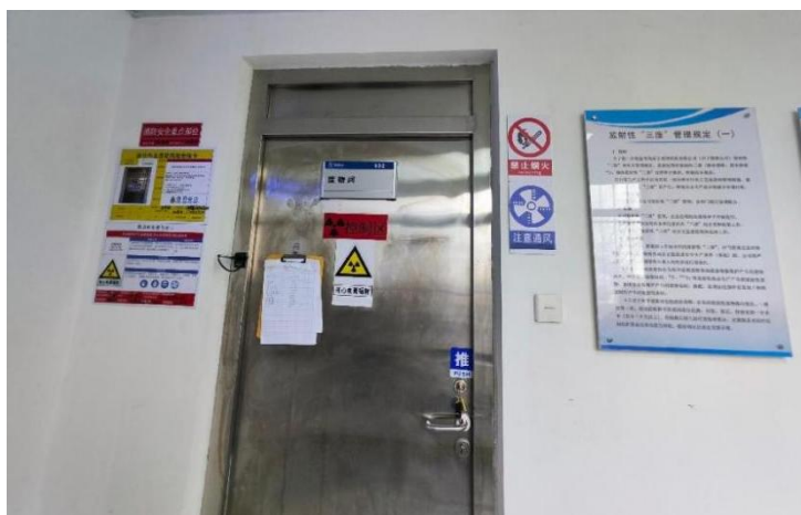
图 5.3-2 废物间双人双锁及电离辐射警告标识
