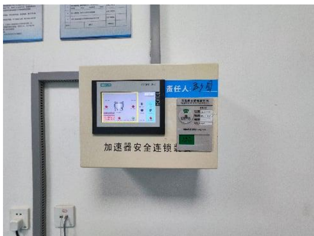
加速器安全连锁装置
