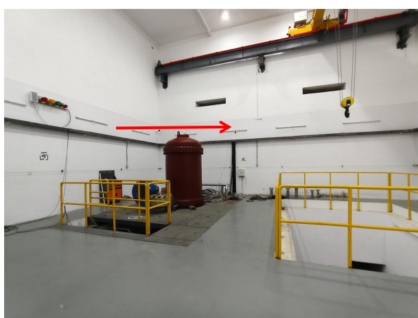
机房东侧（墙外为3#机房内部）
