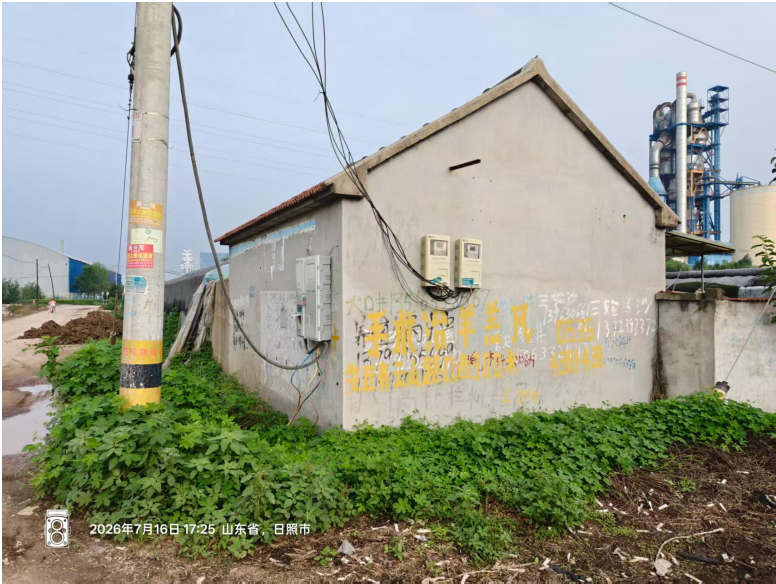
图2-1 变电站南侧17m山头村大棚看护房1
