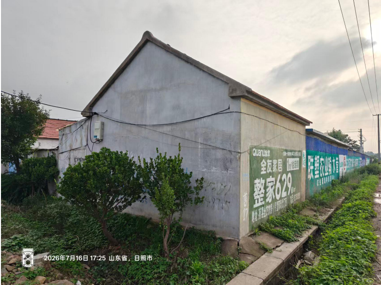
图2-2 变电站南侧18m山头村大棚看护房2
