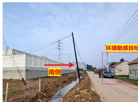
图 4-4 春生 110kV 变电站南侧
