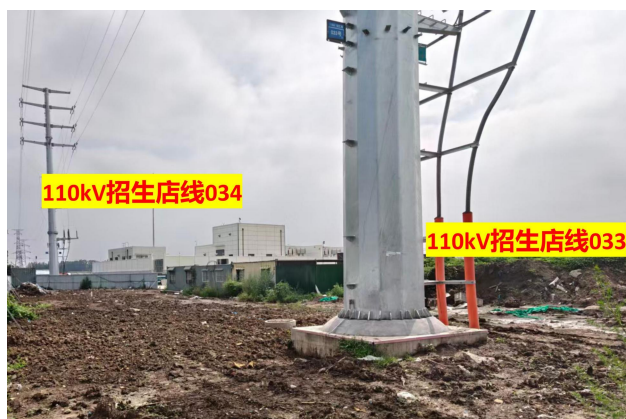
图 6-8 塔基周围土地平整 (110kV 招生店线 033)
