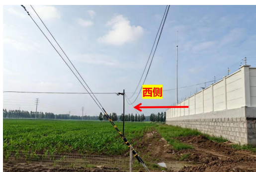
图 4-5 春生 110kV 变电站西侧
