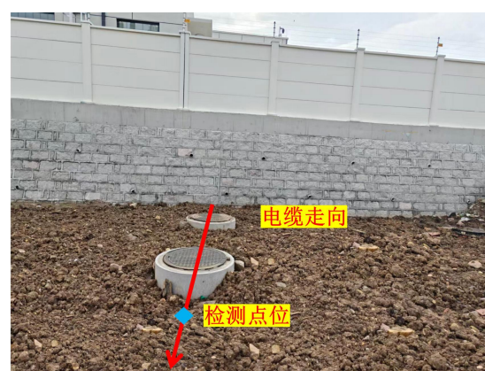
图 7-2 电缆线路检测点位
