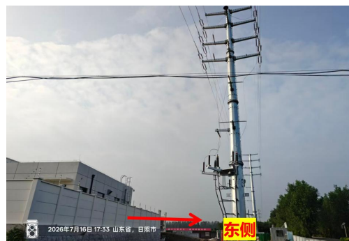
图 4-6 春生 110kV 变电站东侧
