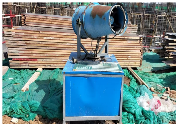
图 6-11 施工期喷洒水降尘设施
