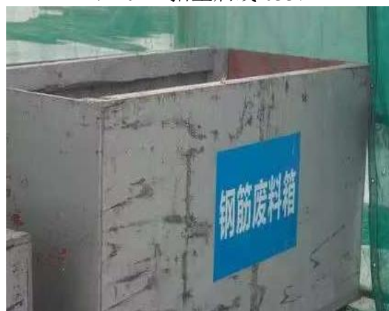
图 6-10 施工固体废物收集箱
