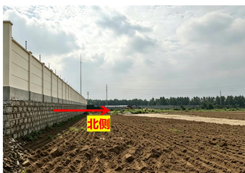
图 4-3 春生 110kV 变电站北侧
