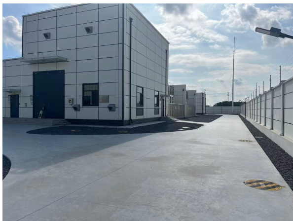
图 6-5 变电站内路面硬化
