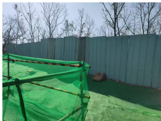
图 6-12 施工期噪声围挡
