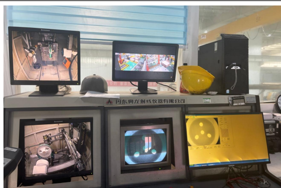
操作室内监控显示器
