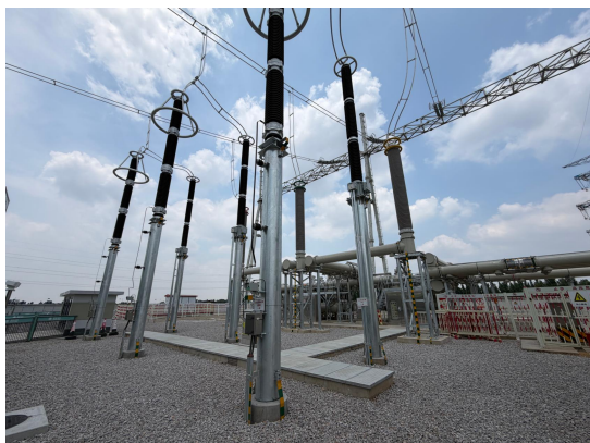
500kV 设备支架及基础
