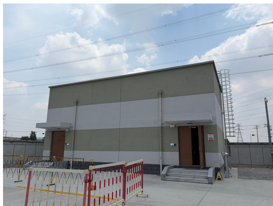
新建水泵房及消防水池
