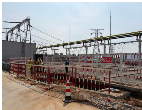
设置施工区域
