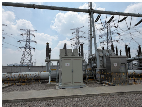
扩建 220kV 间隔
