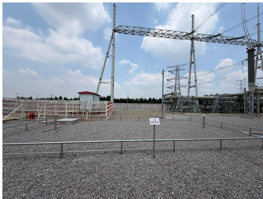
图 11.2-1 本期 2 号事故油池建设情况
