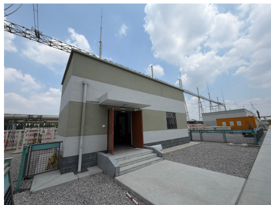
新建雨淋阀室
