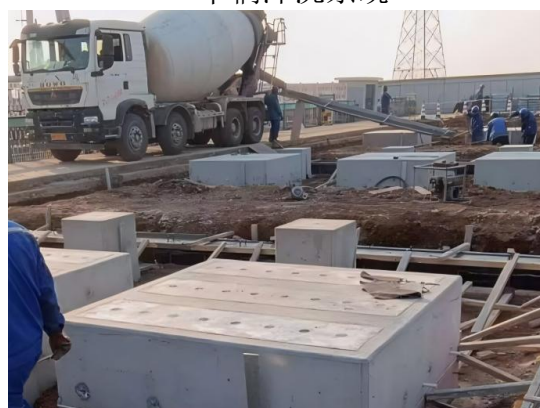
采用商品混凝土现场施工
