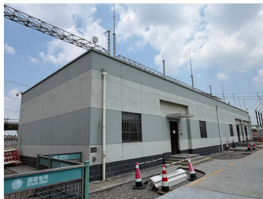
综合继电器室
