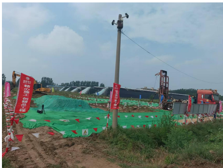
图 6-11 施工期临时苫盖情况
