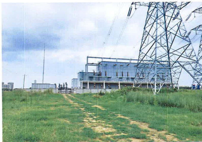
附图 3-2 项目现场照片
