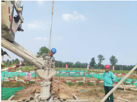
图 6-12 施工期设置施工围挡
