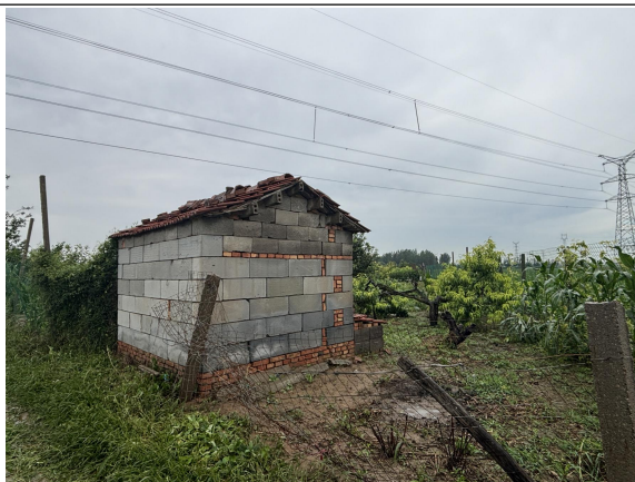
图 2-5 220kV 青蒲I线 26#-27#线南 40m，贾家村看护房
