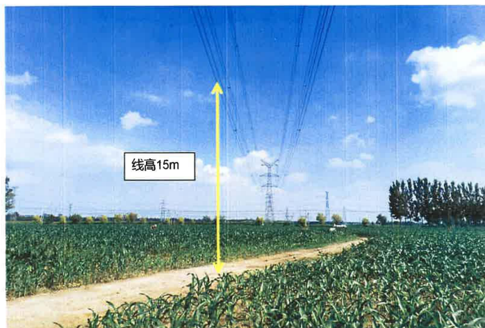
附图 3-4 项目现场照片-220kV 青蒲Ⅱ线/袁蒲线双回架空衰减断面
