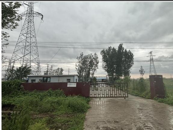
图 2-1 220kV 青蒲I线 1#-3#线下，养牛场
