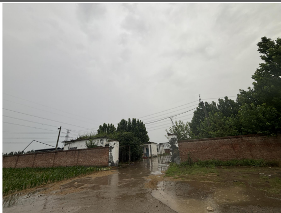
图 2-2 220kV 青蒲I线 3#-4#线东 28m，采油 4 站
