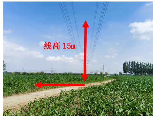
图 7-2 衰减断面 ②220kV 青蒲 II 线 32#-33#/220kV 青蒲线 70#-71#双回架空衰减断面，线高 15m
