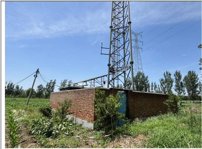
图 2-7 220kV 蒲郭线 5#-6#线南 37m, 移动基站房
