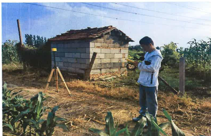
附图 2 项目现场检测照片
