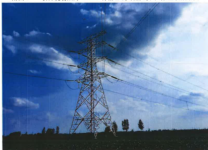
附图 3-5 项目现场照片-220kV 青蒲Ⅱ线单回架空线路下方检测点位
