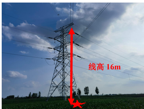
图 7-3 220kV 青蒲 II 线 28#-29#单回架空线路下方
