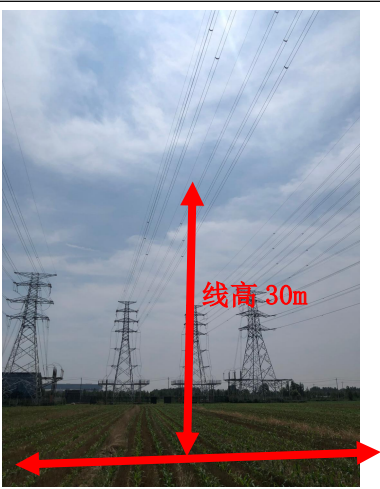
图 7-2 110kV 萃仙线/110kV 萃河线双回架空线路衰减断面（1#-2#杆塔之间，向南、北两侧衰减）
