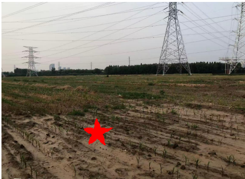
图 7-5 110kV 萃仙线/110kV 萃河线/110kV 萃鹊线/110kV 萃陈线四回电缆线上测点
