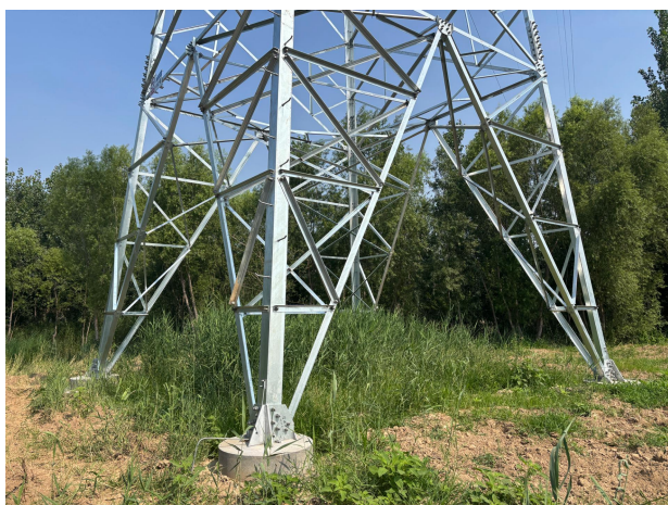
图6-1 塔基周围恢复情况
