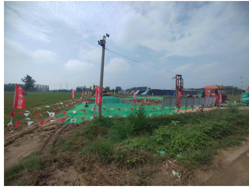
图 6-12 施工期临时苫盖情况
