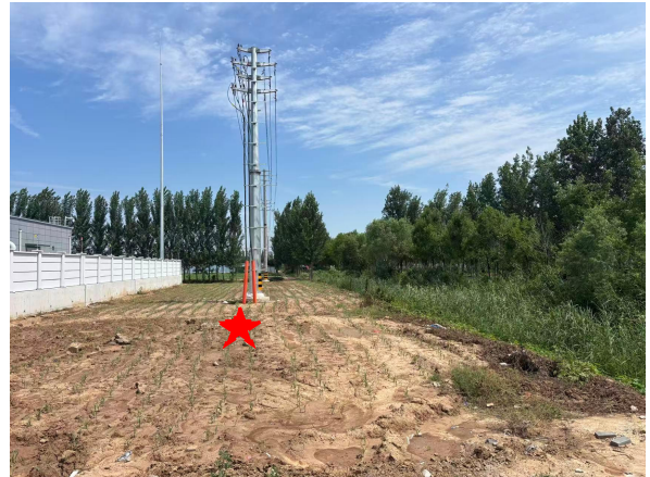
图 7-2 110kV 安文I/II线双回电缆线路线上检测布点
