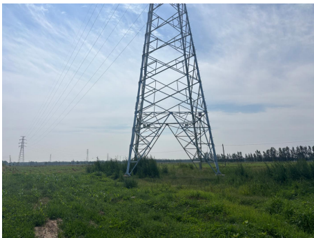
图6-7 塔基周围恢复情况
