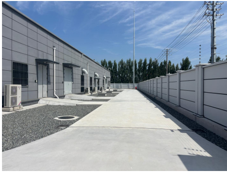
图6-3 变电站内路面硬化
