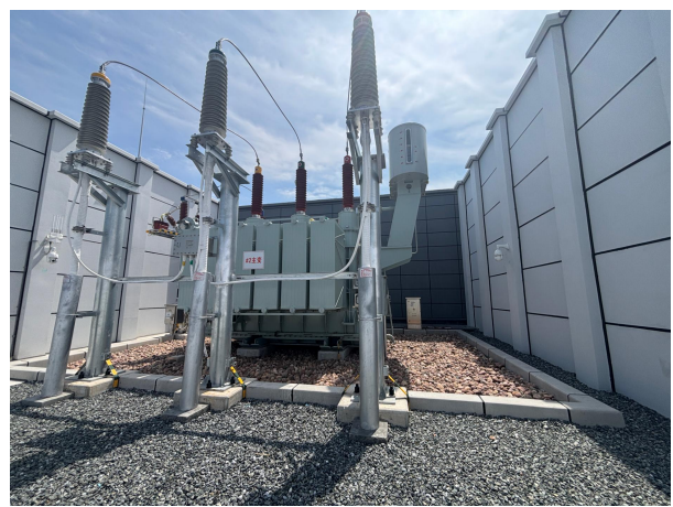
图 4-8 2#主变压器
