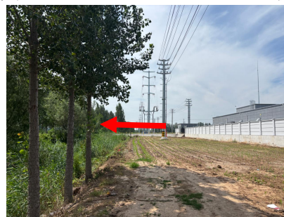
图 4-6 文昌 110kV 变电站东侧
