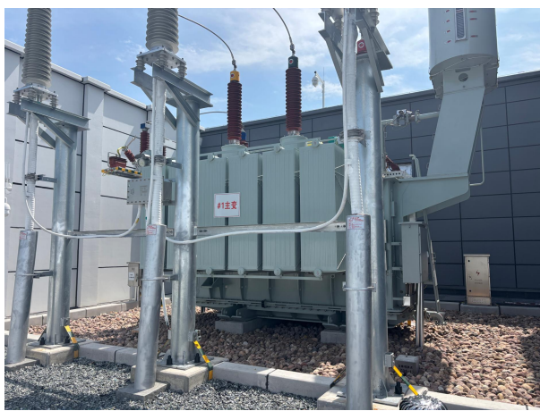
图 4-7 1#主变压器
