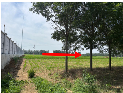
图 4-5 文昌 110kV 变电站西侧
