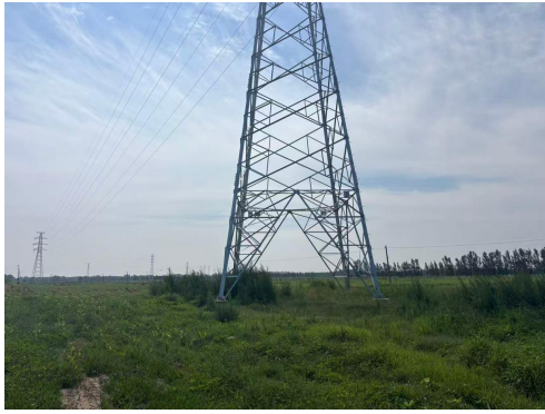
图 6-11 材料场恢复情况
