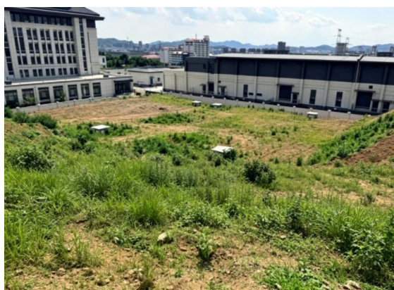
图 6-8 电缆上方恢复情况
