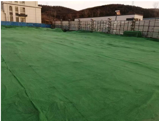
图 6-11 施工期间防尘网
