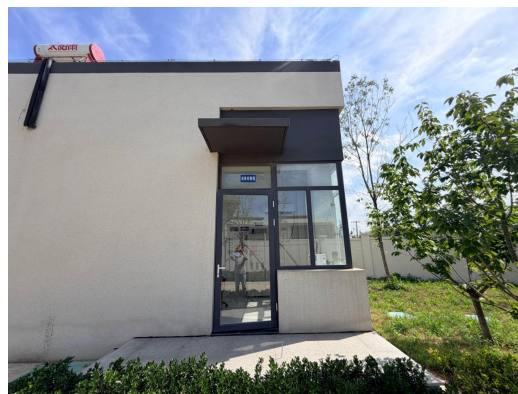
图2-2 变电站南侧12m，门卫室
