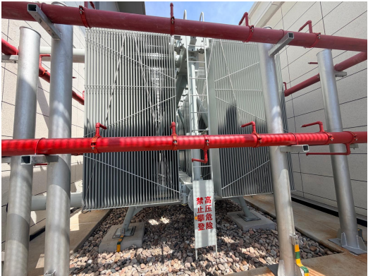
图4-8 #1主变散热器（户外）
