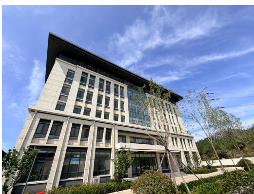
图2-3 变电站东侧4m，电力办公楼
