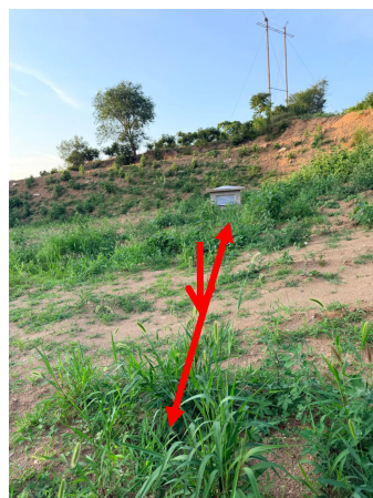
图 7-3 电缆上方检测点
