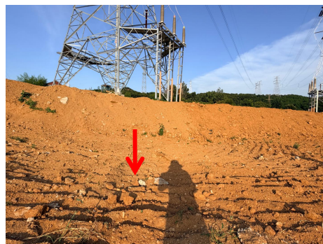
图 7-5 电缆上方检测点
