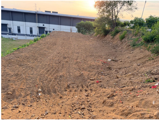
图 6-9 临时占地恢复情况
