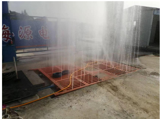
图 6-12 施工期间洒水降尘
