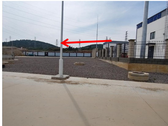
图 4-4 110kV 变电站南侧
