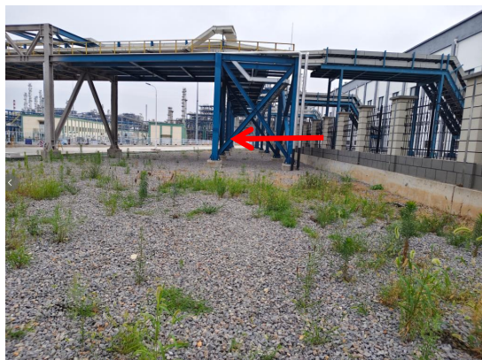
图 4-3 110kV 变电站东侧
