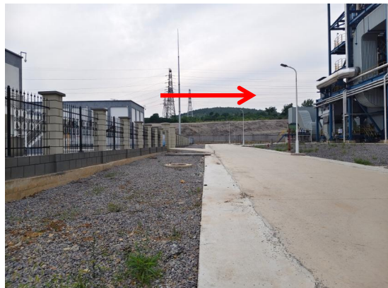
图 4-6 110kV 变电站北侧
