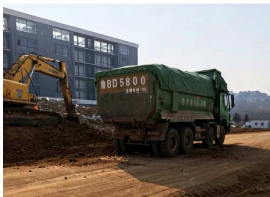
图 6-4 施工期间土方运输车苫盖
