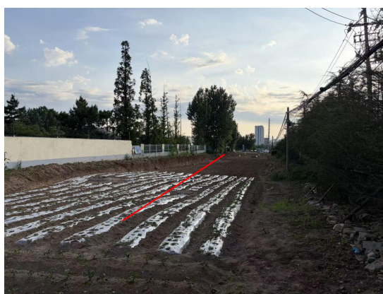
图 6-6 电缆上方恢复情况
