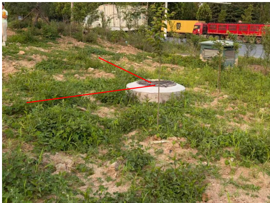
图 6-9 电缆上方恢复情况
