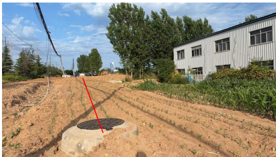
图 6-7 电缆上方恢复情况
