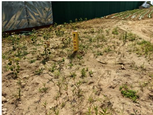
图 6-11 电缆警示防护标志
