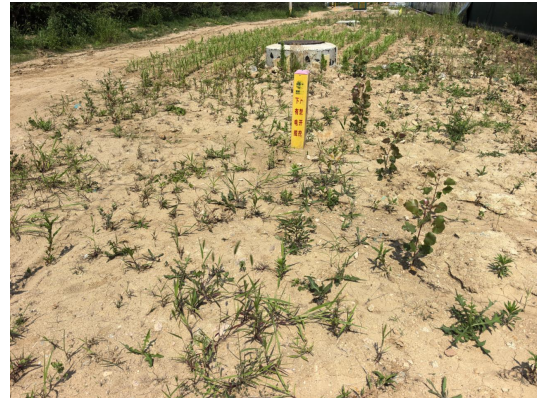
图 6-10 电缆警示防护标志
