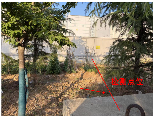
图 7-5 110kV 庄汕线/110kV 松纪线 双回电缆线路
