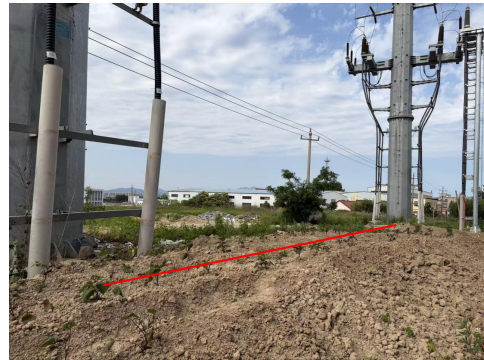
图 6-8 电缆上方恢复情况
