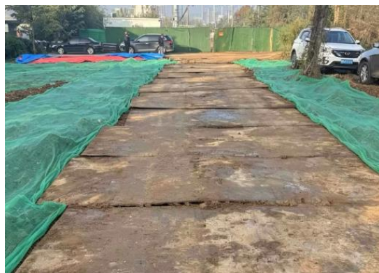
图 6-2 施工期间铺设钢板
