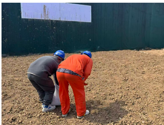
图 6-5 施工结束后播撒草籽
