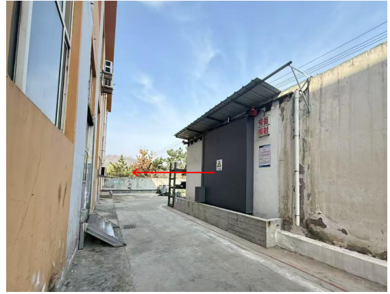
探伤室南侧（装配车间）
