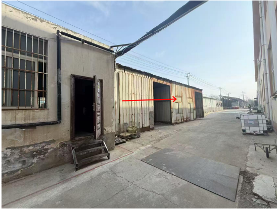
探伤室东侧（模具库 1、2）
