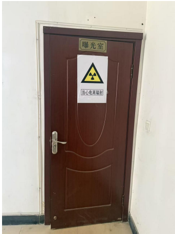
图 3-3 迷道外口防护门 电离辐射警告标志
