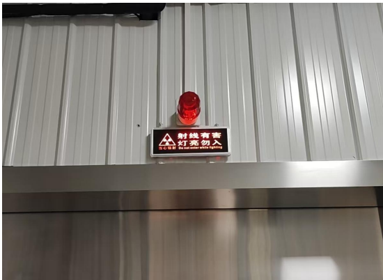
防护门上方工作状态指示灯（带声音提示装置）
