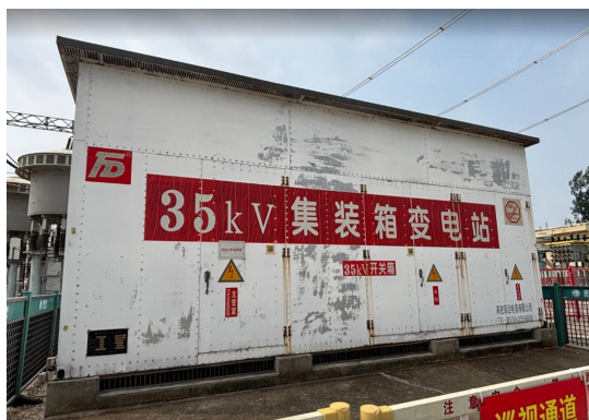
35kV 集装箱式变压器
