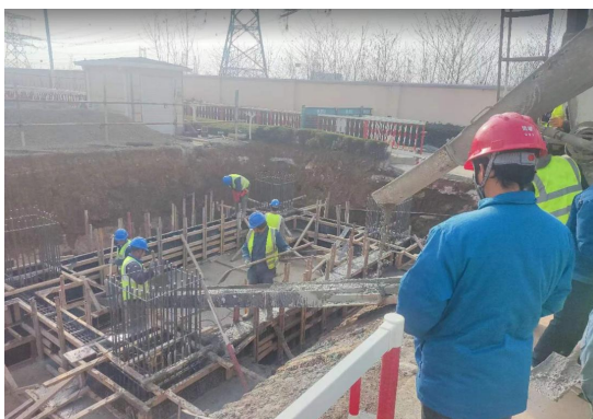
采用商品混凝土现场施工照片
