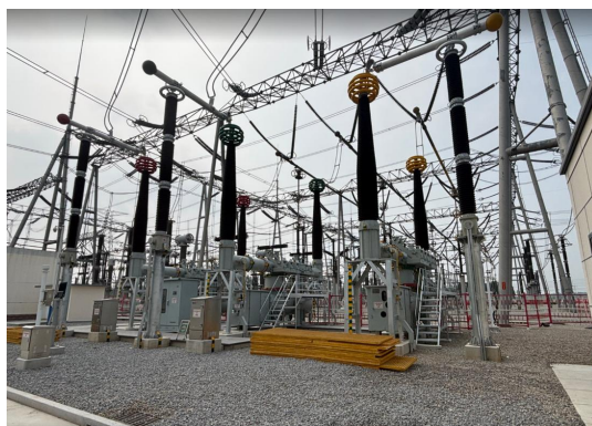
新增 500kV 配电装置采用户外 HGIS
