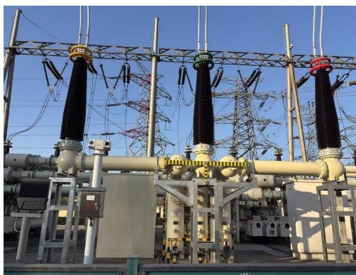
新增 220kV 配电装置采用户外 GIS
