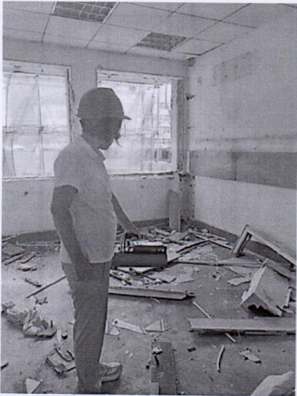
图 3 现场检测照片
