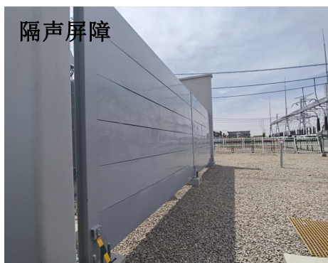
图 5.3-2 调试期环保照片
