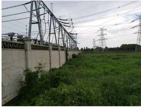
图 6.2-2 500kV 临潍线改建工程沿线生态环境情况
