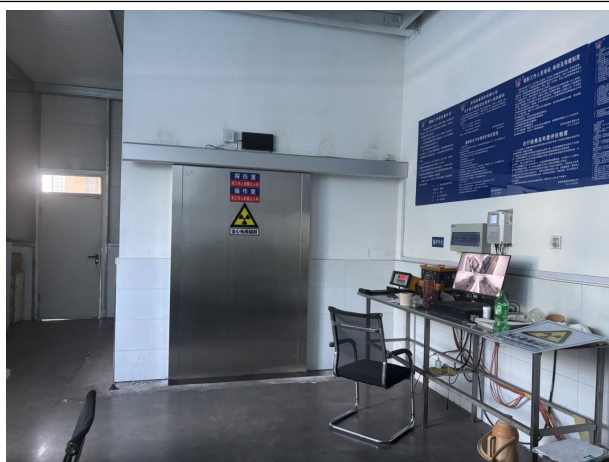
小防护门、电离辐射警告标志、工作状态指示灯
