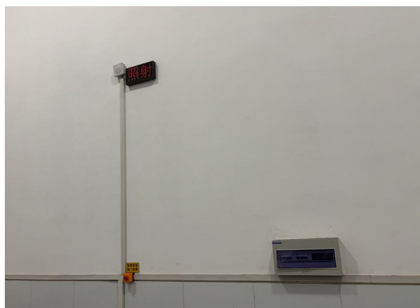
曝光室内声音提示装置
