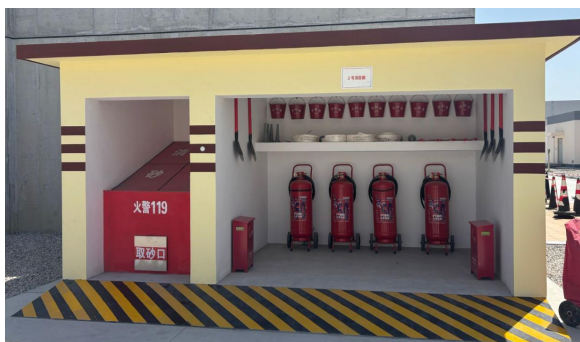
新建 2 号消防棚
