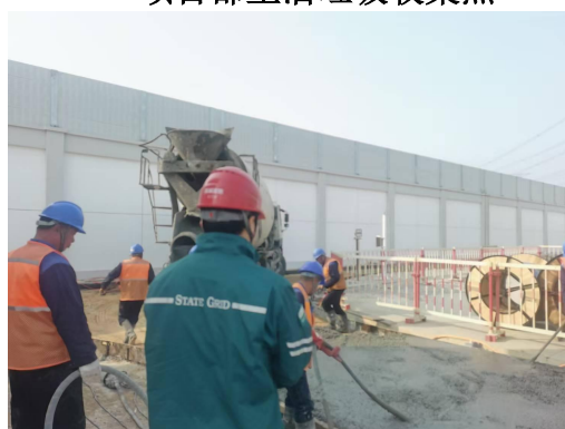
采用商品混凝土现场施工照片
