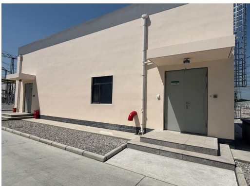
新建综合水泵房及消防水池
