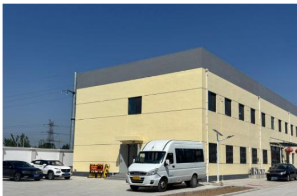
新建值班综合楼
