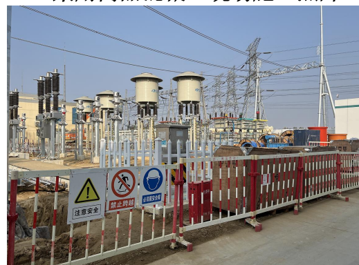
设置施工区域
