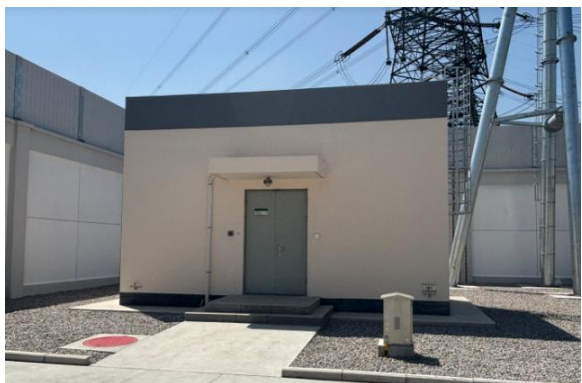
新建雨淋阀室
