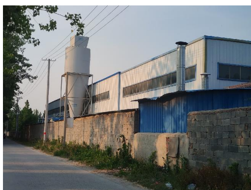
图 2-5 110kV 忠孔线 24#~25#线东 18m 山东华奥印刷公司厂房
