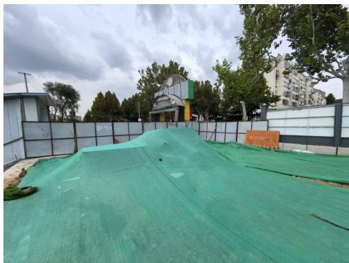
图6-5 变电站施工建筑垃圾临时堆存防尘网
