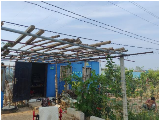
图 2-9 110kV 忠孔线 27#~28#线西 15m 凤山社区西看护房 2
