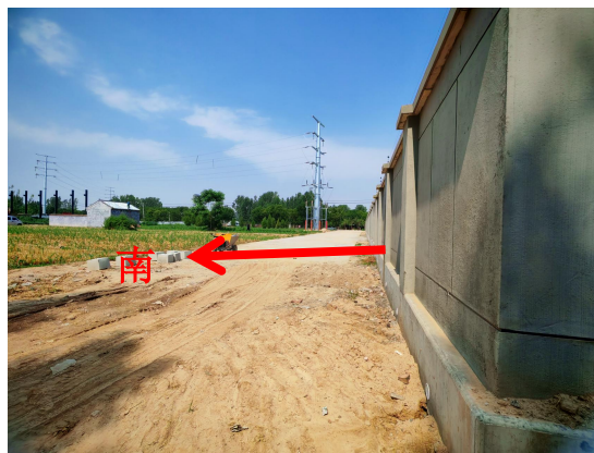
图 4-4 济宁梁山孔坊 110kV 变电站南侧
