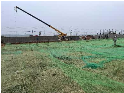
图6-1 变电站施工防尘网措施
