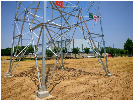
图6-11 110kV 忠孔线84#/110kV 徐梁线孔坊分支32#塔基附近植被恢复情况
