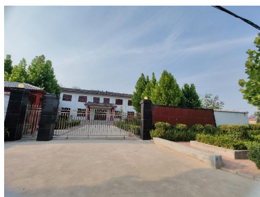
图 2-6 110kV 忠孔线 24#~25#线西 20m 华奥印刷公司西建筑
