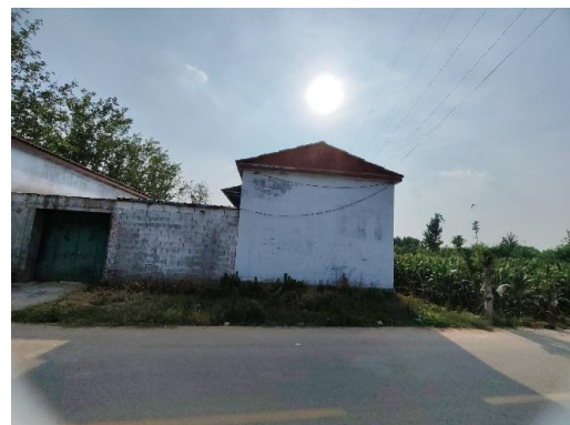
图 2-12 110kV 忠孔线 42#~43#最近线 南 18.5m 李庄村西南民房
