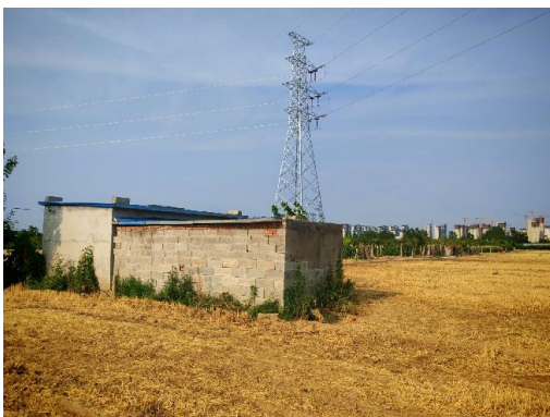
图 2-11 110kV 忠孔线 33#~34#线西 20m 薛屯村东南看护房
