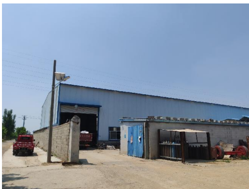
图 2-15 110kV 忠孔线 83#/110kV 梁徐线孔坊分支 31#~110kV 忠孔线 84#/110kV 梁徐线孔坊分支 32#线北 28m 西吴庄东南工厂
