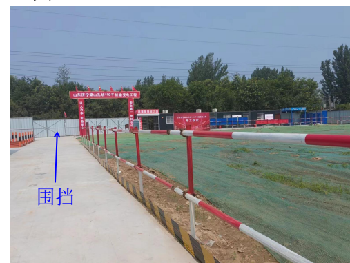
图6-6 变电站施工围挡措施
