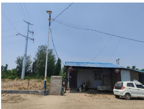
图 2-29 110kV 梁徐线孔坊分支 4#~5#线 北 10.5m 汽车修理站看护房
