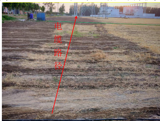
图6-24 单回电缆电缆沟上方恢复
