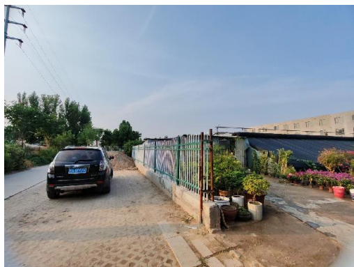
图 2-3 110kV 忠孔线 23#~24#最近线西 9m 梁山现代高中东侧道路两侧看护房
