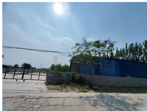
图 2-14 110kV 忠孔线 70#~71#最近线北 1m 东杨集村东南地磅房
