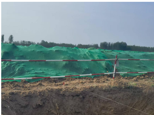
图6-10 塔基周围设置施工边界
