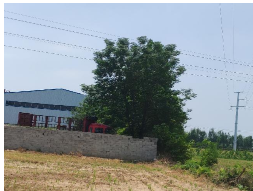
图 2-28 110kV 梁徐线孔坊分支 5#~6# 线东 15.0m 梁山宇润商贸公司厂房
