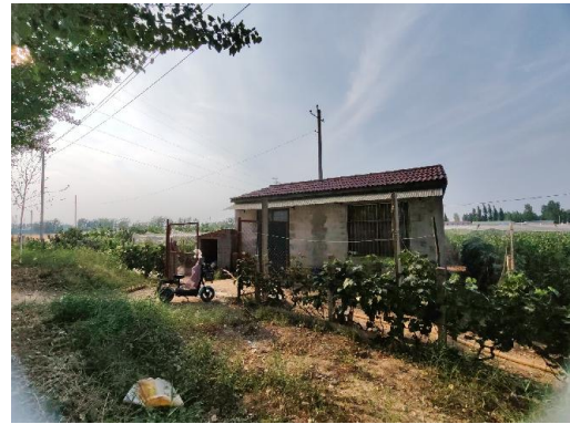
图 2-10 110kV 忠孔线 32#~33#线东 30m 梁五路北看护房
