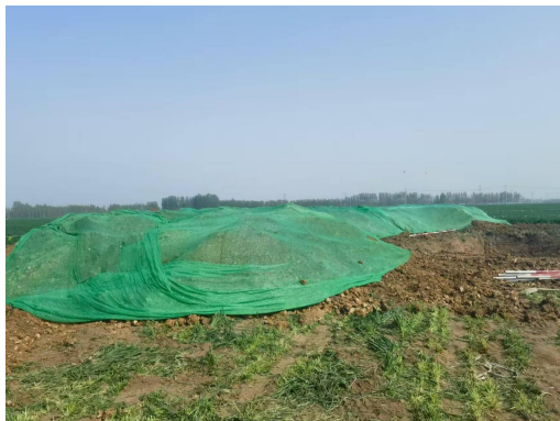
图6-9 塔基施工表土堆存设置防尘网
