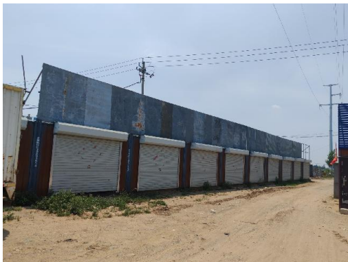
图 2-25 110kV 梁徐线孔坊分支 9#~10#线 南 2mS321 南侧门头房
