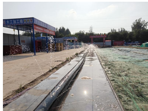
图6-2 变电站洒水抑尘措施
