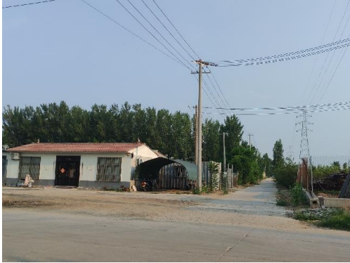
图 2-7 110kV 忠孔线 24#~25#线东 21m 华奥印刷南道路两侧看护房
