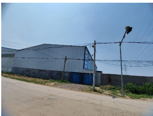
图 2-17 110kV 忠孔线 85#/110kV 梁徐线孔坊分支 33#~110kV 忠孔线 86#/110kV 梁徐线孔坊分支 34#线东 19m 后杨楼小学东南工厂
