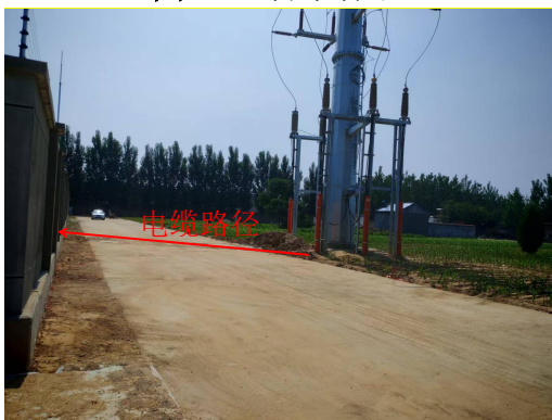
图6-23 双回电缆电缆沟上方硬化
