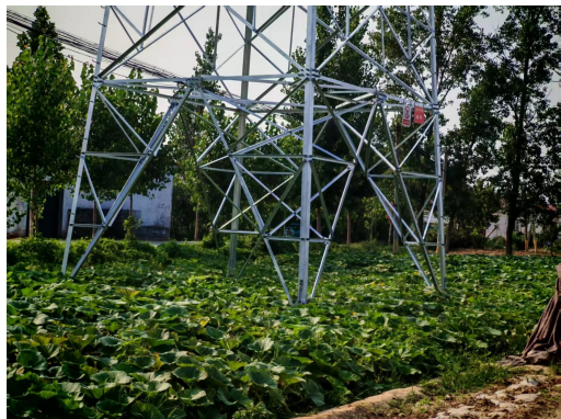
图6-22 110kV 忠孔线43#塔基下方恢复
