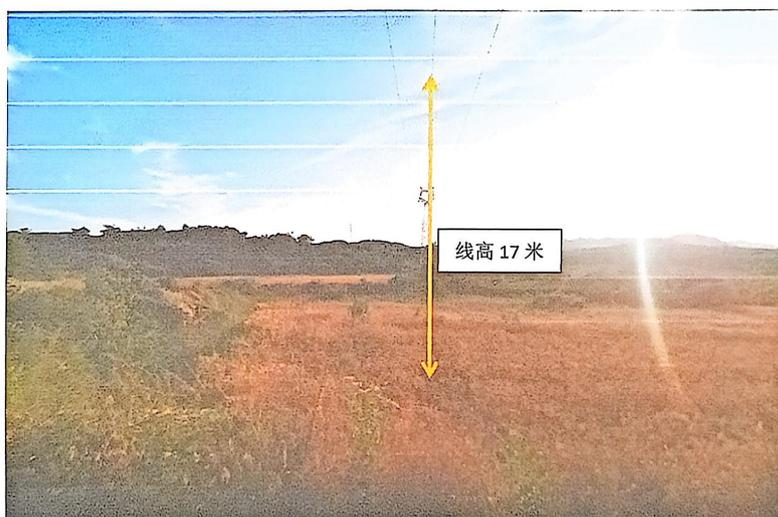
附图 2-2 110kV 荣工线 061#-062#单回架空衰减断面，线高 17m。
