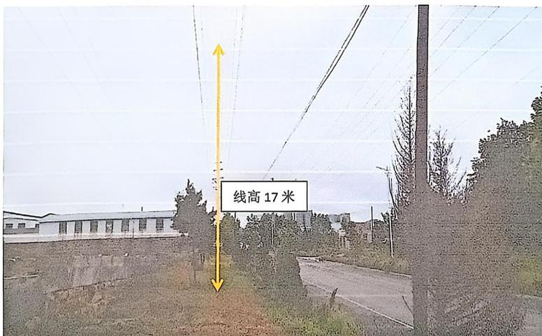
附图 2-4 110kV 荣工线 066#-067#/110kV 益俐线 063#-064#双回架空线路衰减断面，线高 17m。
