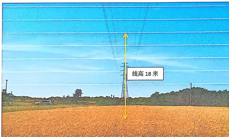
附图 2-1 110kV 益工线 044#-045#/110kV 益俐线 044#-045#双回架空衰减断面，线高 18m。
