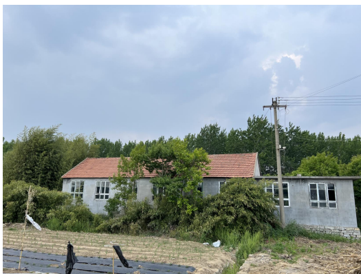
图2-3 110kV泽固线#28~#32/110kV银白线#156~#159线路北侧, 万家庄北侧民房
