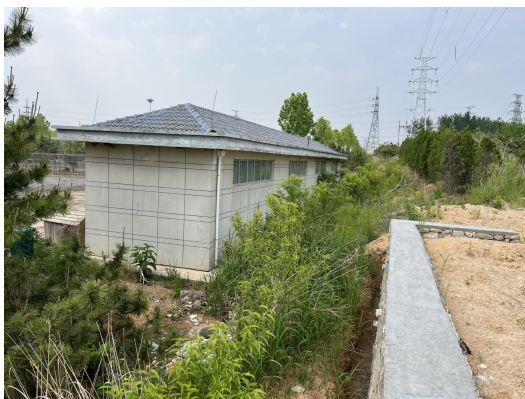
图2-1 110kV泽固线#1~#2/110kV泽白线#1~#2线路西侧10m, 停车场看护房
