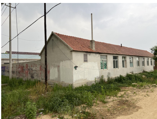
图2-5 110kV泽固线#47~#48/110kV银白线#138~#139线路北侧15m, 东瓦砌埠村北侧工厂
