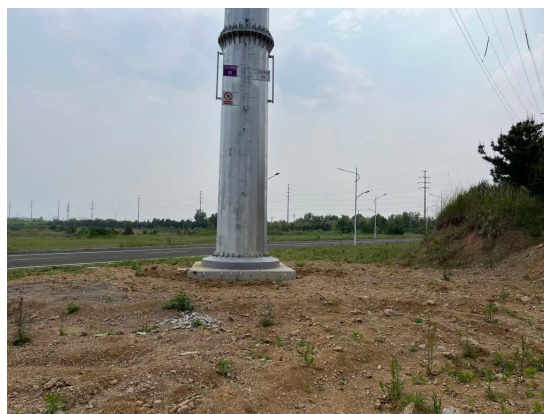
图 6-8 110kV 泽固线#3/110kV 泽白线 #3 杆塔下方恢复情况
