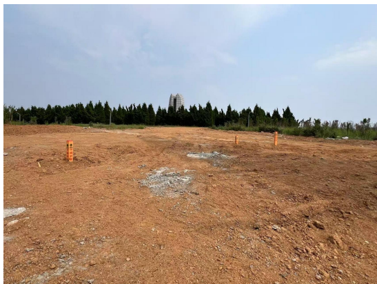
图 6-12 电缆沟上方恢复情况
