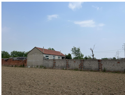
图2-2 110kV泽固线#27~#28/110kV银白线#159~#160线路东北侧23m, 万家庄东北侧民房
