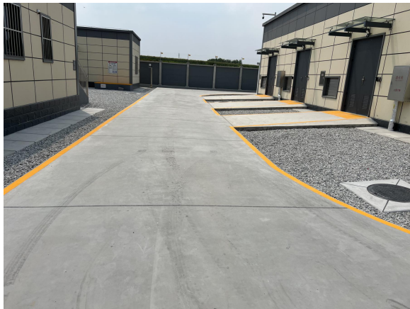
图 6-1 站内路面硬化情况
