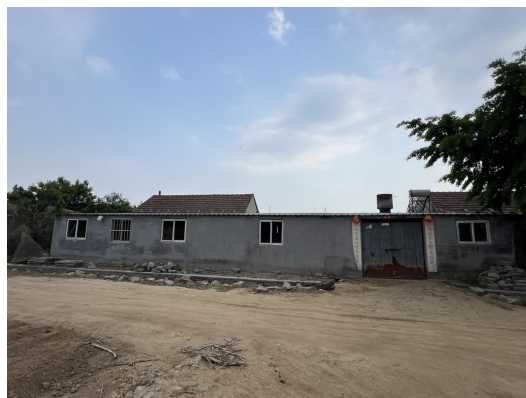
图2-4 110kV泽固线#32~#33/110kV银白线#155~#156线路东南侧25m, 万家庄村西侧养殖看护房
