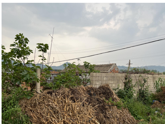
图2-9 110kV泽崮线#109~#110/110kV银白线#78~#77线路东南侧15m, 大浩口村东南偏东看护房1
