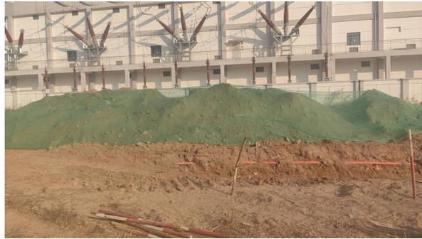
图6-9 电缆施工开挖土堆防风抑尘网
