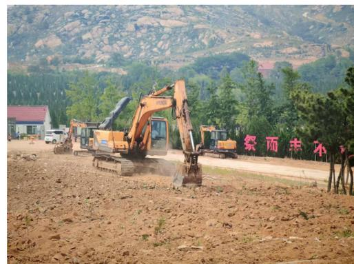
图6-4 施工结束后挖掘机进行土地平整
