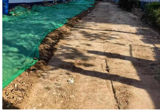
图6-2 施工防风抑尘网
