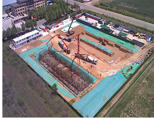
图 6-10 施工期间施工围挡及防尘网落实照片
