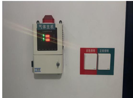
图 6-2 SF<sub>6</sub>报警装置
