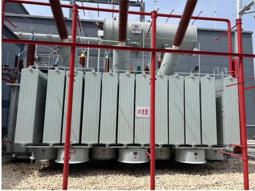
图4-7 #1主变压器（户外）
