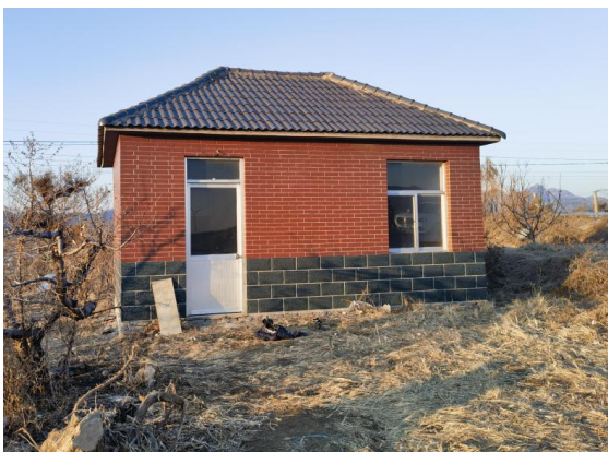
图 2-27 220kV 郁凤线 096#~097#线北 7m，寨子村西南侧看护房 1
