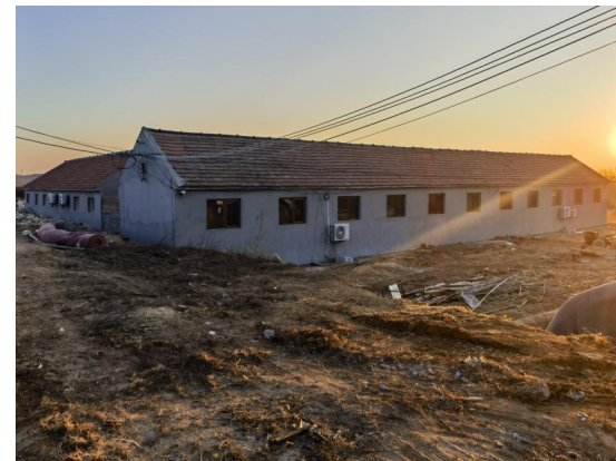
图 2-28 220kV 郁凤线 096#~097#线南 22m，寨子村西南侧看护房 2
