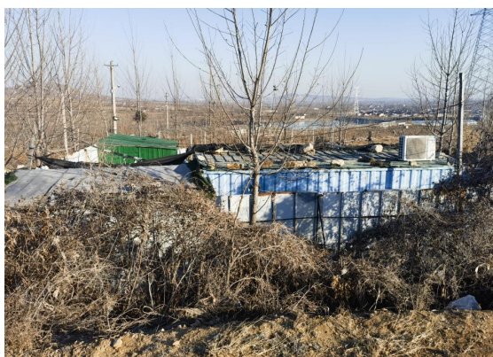
图 2-33 220kV 郁凤线 108#~109#线 下, 西丁家村西北侧看护房
