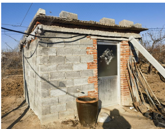
图 2-35 220kV 郁凤线 111#~112#线 下, 西丁家村北侧看护房 1
