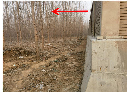
图 4-6 郁秩 220kV 变电站北侧
