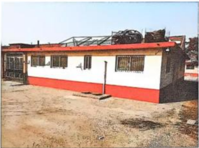
附图 4 项目现场照片
