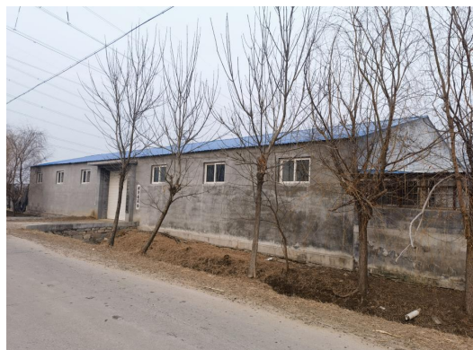
图 2-2 220kV 泽郁线 165#~166#、220kV 郁铁 I 线 013#~014#线东南 26m, 平度市新河镇华祥农场
