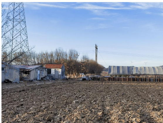
图 2-23 220kV 郁凤线 094#~095#线南 40m, 北台村东北侧看护房 1
