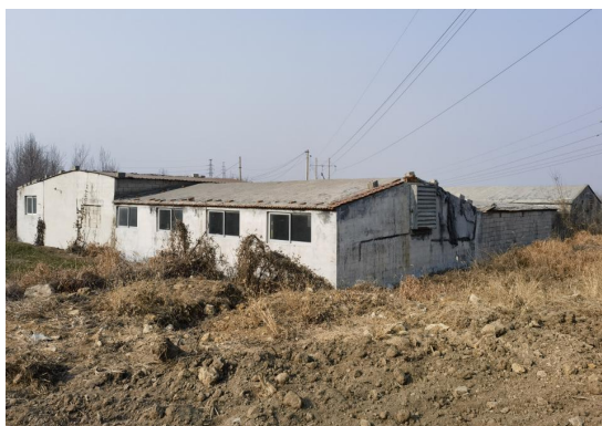
图 2-9 220kV 郁凤线 067#~068#线北 32m, 河南村东南侧看护房 2
