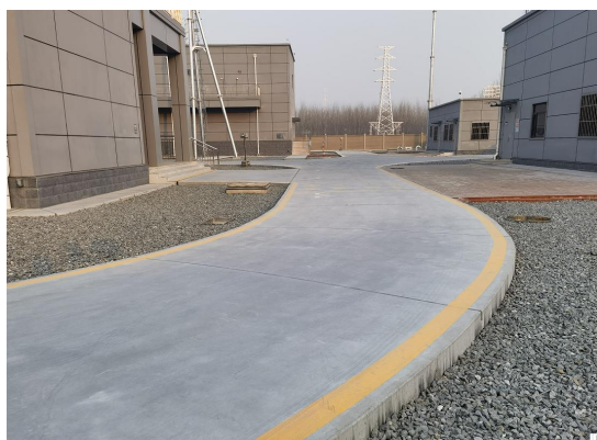
图 6-5 变电站内路面硬化
