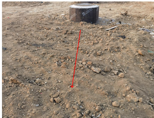
图 6-2 电缆沟周边恢复
