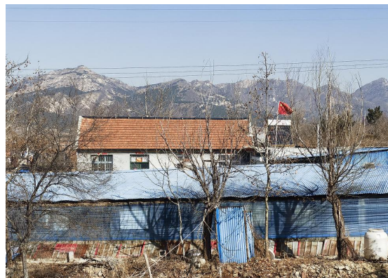
图 2-30 220kV 郁凤线 098#~099#线北 39m，寨子村南侧看护房
