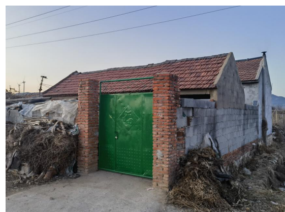
图 2-24 220kV 郁凤线 094#~095#线北 32m, 北台村东北侧看护房 2
