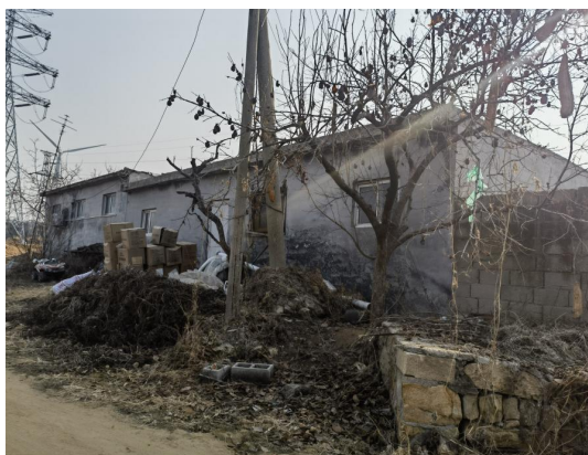
图 2-21 220kV 郁凤线 082#~083#线西南 22m, 西蟠桃山村南侧看护房
