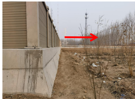
图 4-4 郁秩 220kV 变电站南侧
