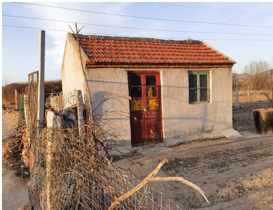
图 2-25 220kV 郁凤线 094#~095#线 下，北台村东北侧看护房 3
