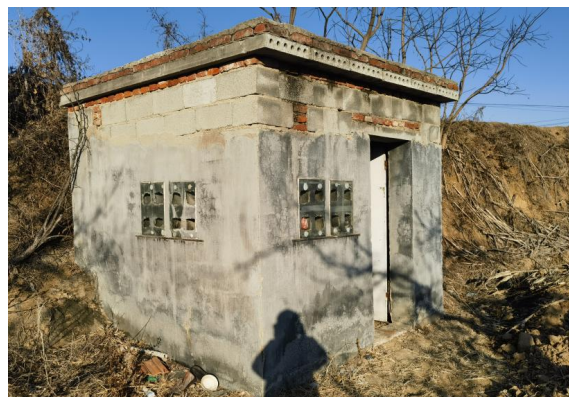
图 2-32 220kV 郁凤线 105#~106#线南 12m, 北潘家村东南看护房
