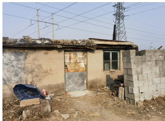
图 2-8 220kV 郁凤线 066#~067#线南 33m, 河南村东南侧看护房 1
