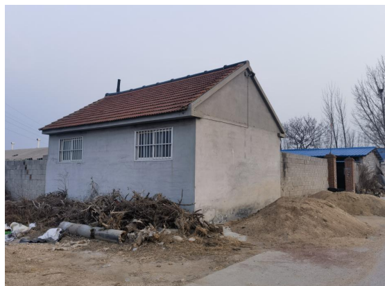
图 2-3 220kV 泽郁线 166#~167#、220kV 郁铁 I 线 012#~013#线东南 37m, 潘家洼村养殖看护房
