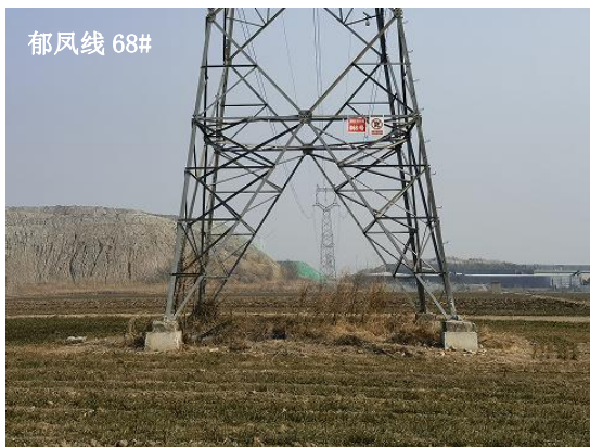
图 6-1 塔基周边恢复
