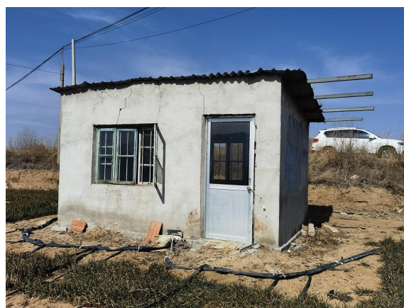
图 2-36 220kV 郁凤线 111#~112#线北 35m, 西丁家村北侧看护房 2
