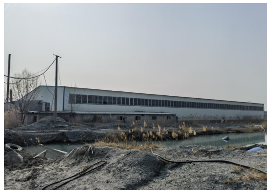
图 2-10 220kV 郁凤线 69#~70#线南 17m, 青岛福鑫石墨有限公司厂房
