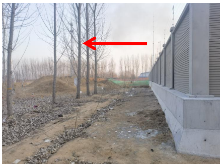
图 4-3 郁秩 220kV 变电站东侧
