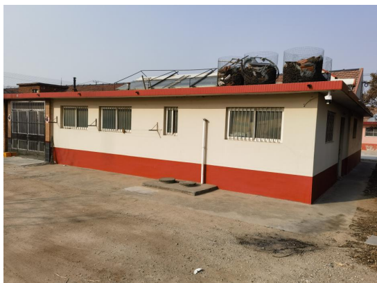
图 2-7 220kV 郁凤线 065#~066#线西北 40m, 河南村南侧的民房
