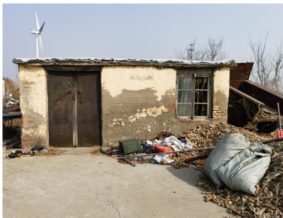
图 2-13 220kV 郁凤线 73#~74#线北 26m, 荆家寨村东北侧看护房
