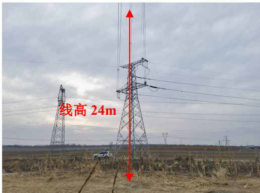
图 7-12 220kV 郁铁 I 线单回架空线 下方
