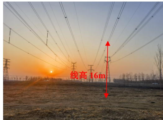
图 7-11 220kV 郁铁 II 线单回架空线 路下方
