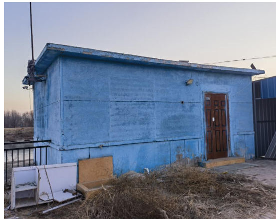
图 2-26 220kV 郁凤线 094#~095#线南 12m，北台村东北侧垂钓园
