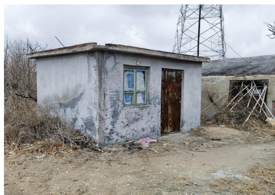
图 2-5 220kV 郁唐线 066#~067#线西 28m, 河南村南侧看护房 1
