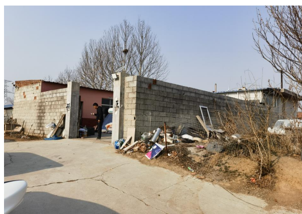
图 2-18 220kV 郁凤线 081#~082#线北 31m, 西蟠桃山村西南侧看护房 1
