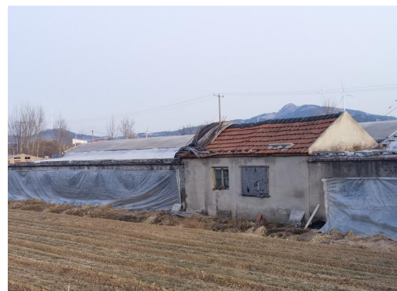
图 2-22 220kV 郁凤线 093#~094#线南 32m, 北台村北侧看护房
