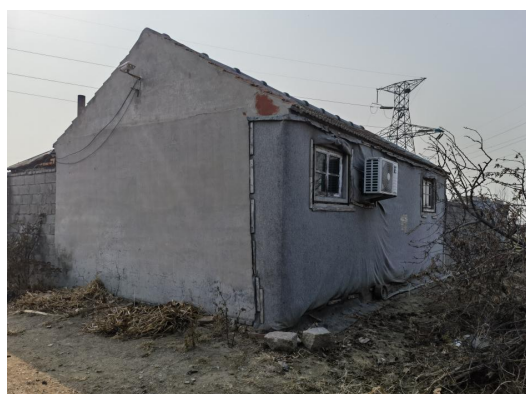
图 2-6 220kV 郁唐线 066#~067#线西 18m, 河南村南侧看护房 2
