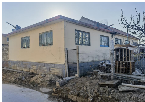
图 2-34 220kV 郁凤线 111#~112#线南 26m, 西丁家村北侧民房
