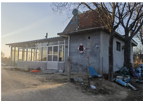
图 2-29 220kV 郁凤线 097#~098#线南 19m，寨子村西南侧看护房 3
