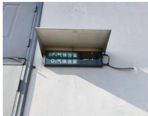
图6-6 220kV SF6泄露报警器
