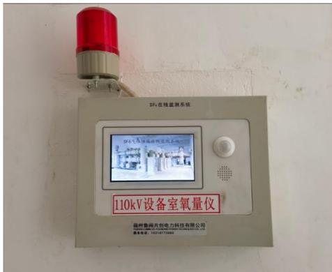
图6-5 110kV SF6泄露报警器
