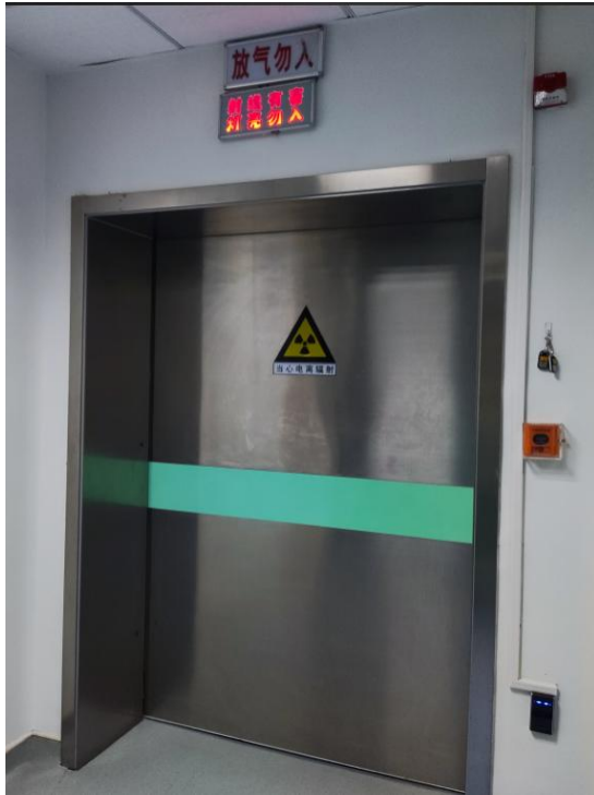
患者进出防护门工作状态指示灯、电离辐射警示标志
