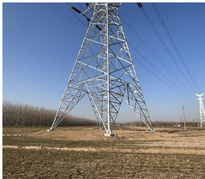
图6-1 220kV 韶旭 I 线25#/韶旭II线25# 塔基周围恢复情况
