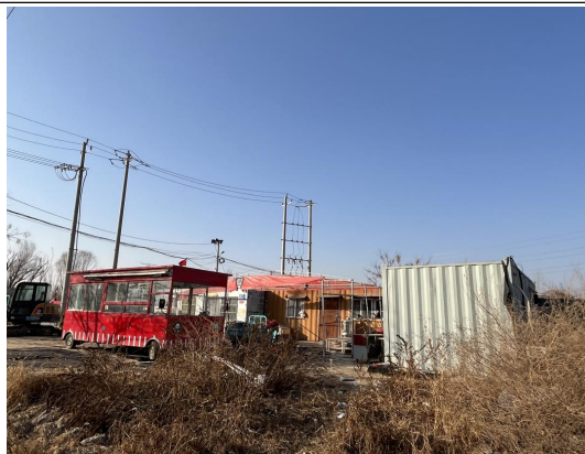
图 2-2 220kV 韶旭 I 27#~28#/220kV 韶旭 II 线 29#~30#线西 14m 大路村民房
