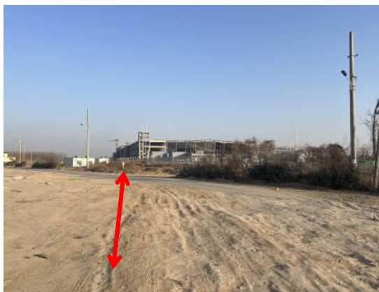
图6-5 电缆敷设恢复情况
