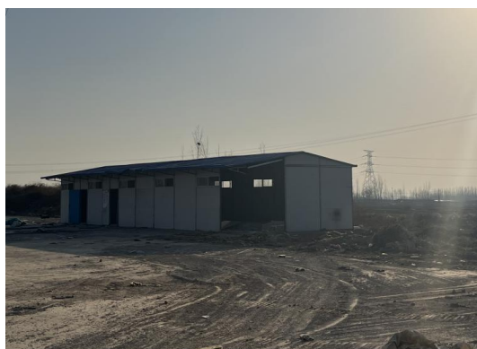
图 2-4 220kV 韶旭 I 28#~29#/220kV 韶旭 II 线 30#~31#线 下大路村南施工板房（不属于本项目）
