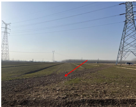
图6-3 临时道路恢复情况
