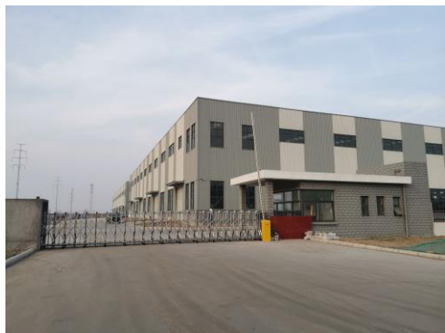
图2-3 110kV岚义I、II线#5-#7线东22m阳森供应链管理（日照）有限公司
