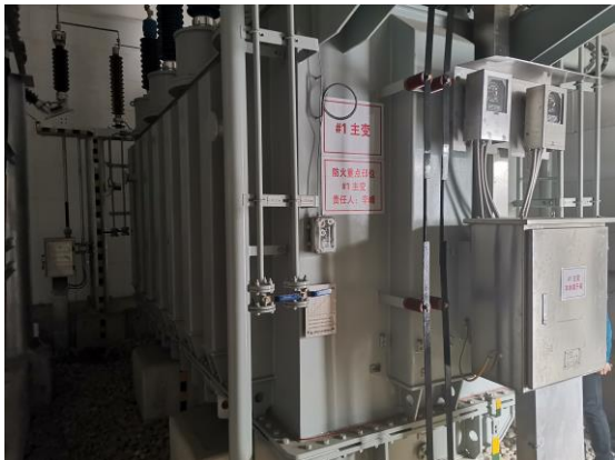
图 4-7 #1 主变压器
