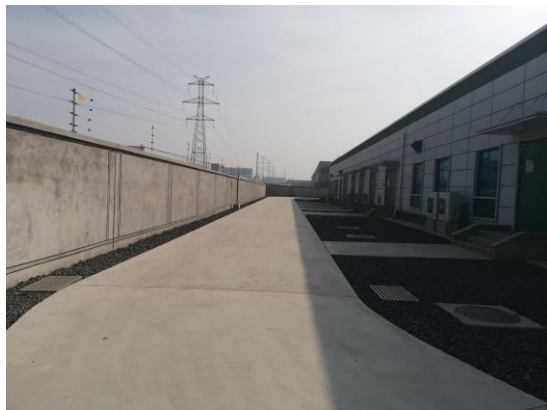
图6-5 路面硬化
