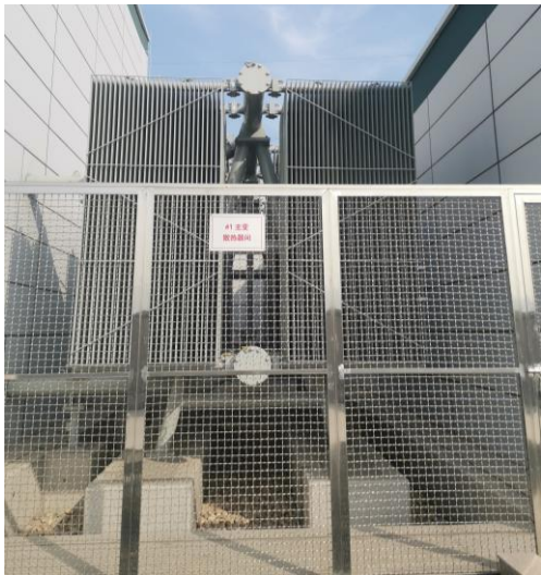
图 4-9 #1 主变散热器
