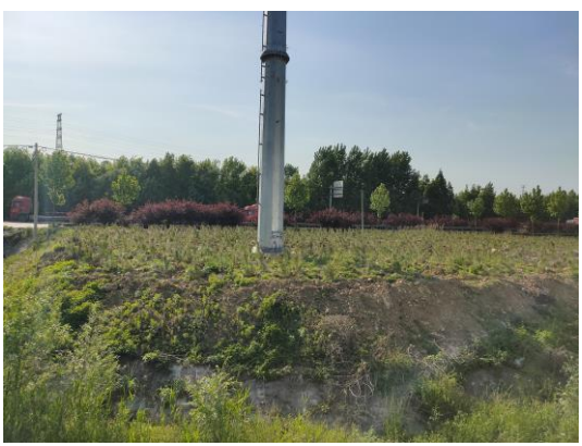
图6-6 塔基周围土地恢复
