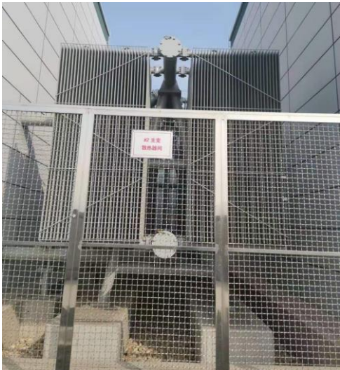
图 4-10 #2 主变散热器
